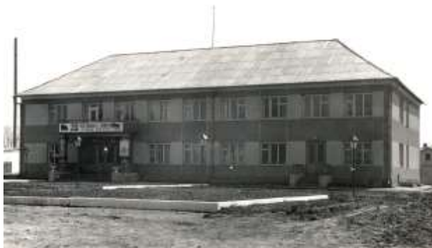
Приміщення нової контори і сільської ради.
